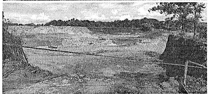
Cantera realizada por Lampa, en forma vertical y sin taludes al borde del camino (donde se encuentra la camioneta).
